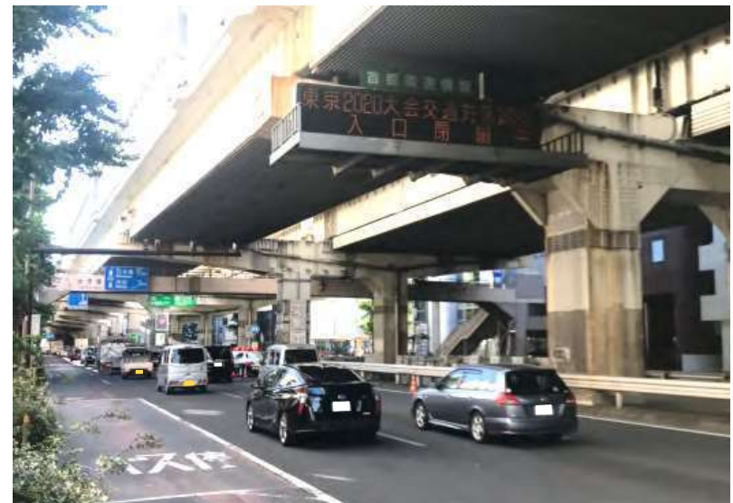
入口閉鎖（国道246号 三軒茶屋入口周辺）
