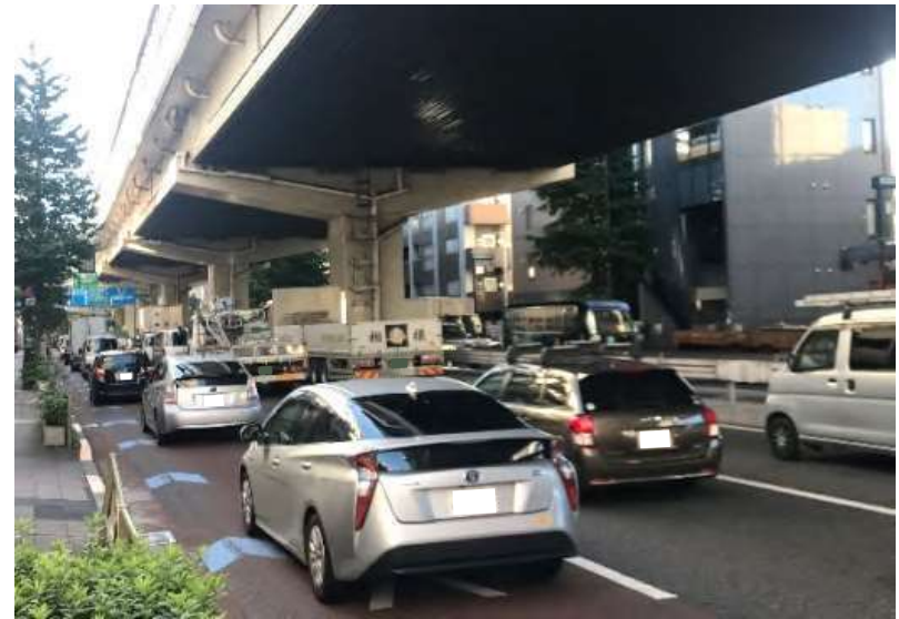
環状七号線外側（国道246号 上馬交差点付近）
